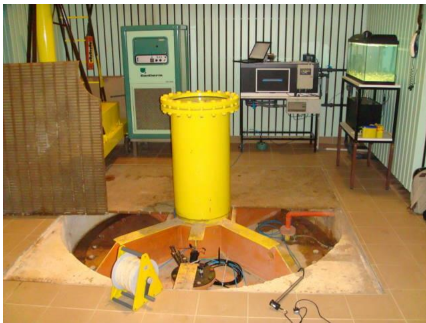
Illustration 16 : Forage n°4 de la chambre de captage de la source du Lez
